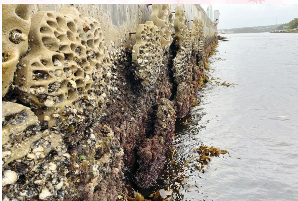
Hình 1. Cấu trúc tấm panel 3D làm từ vật liệu tái chế để tạo bờ kè sinh thái tại Sydney [1]
